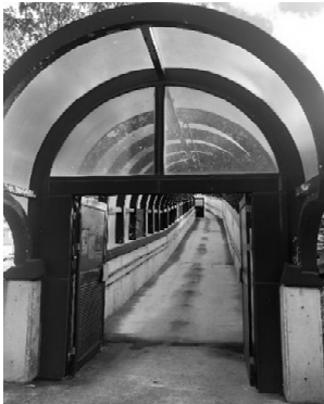
写真8 ドーム式避難路
