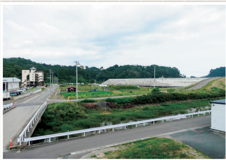
田老第二防潮堤(宮古市)
