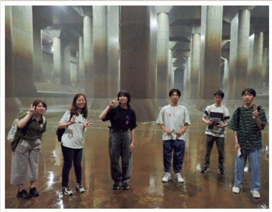
首都圏外郭放水路集合写真
