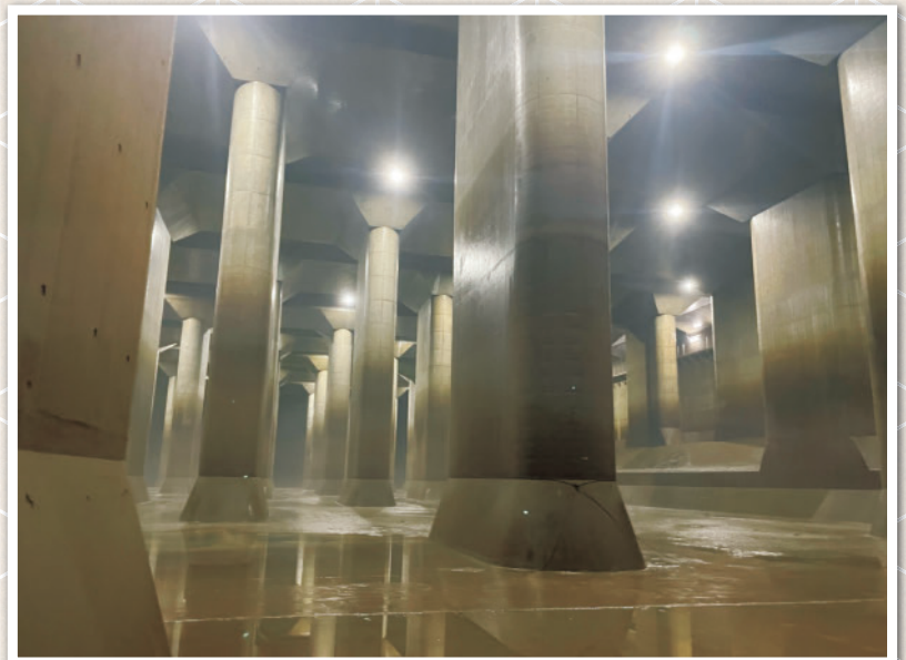
首都圏外郭放水路③
