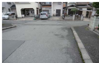
図3 道路を盛土にしている例
